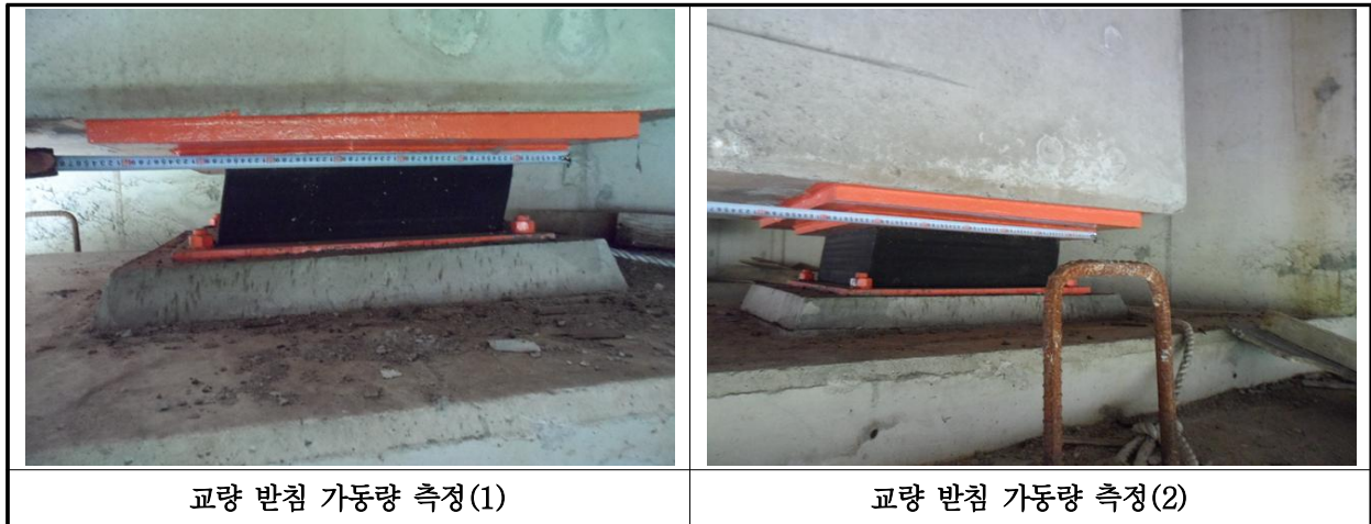
【사진 38.3.13】 교량받침(서울방향) 이동량 측정
