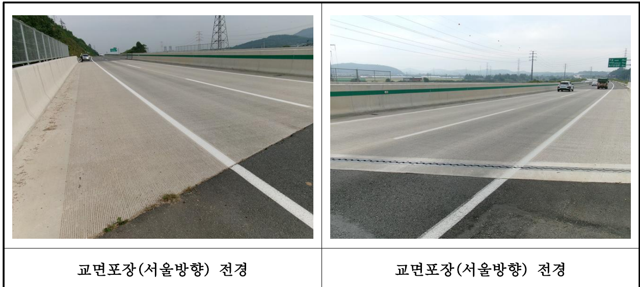
【사진 38.3.17】 교면포장(서울방향) 전경
