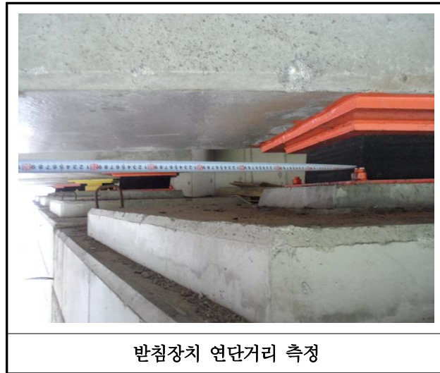
【사진 38.3.12】 교량받침장치 연단거리측정
