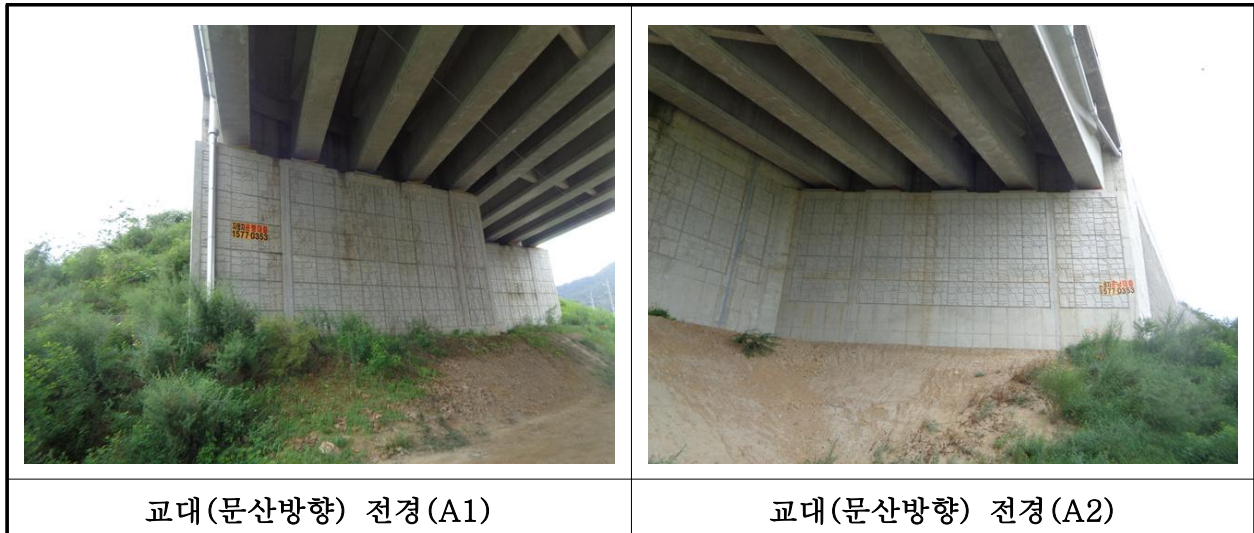
【사진 38.3.29】 교대(문산방향) 전경
