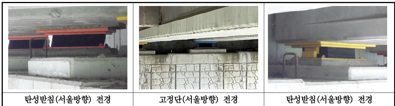
【사진 38.3.10】 교량받침(서울방향) 전경
