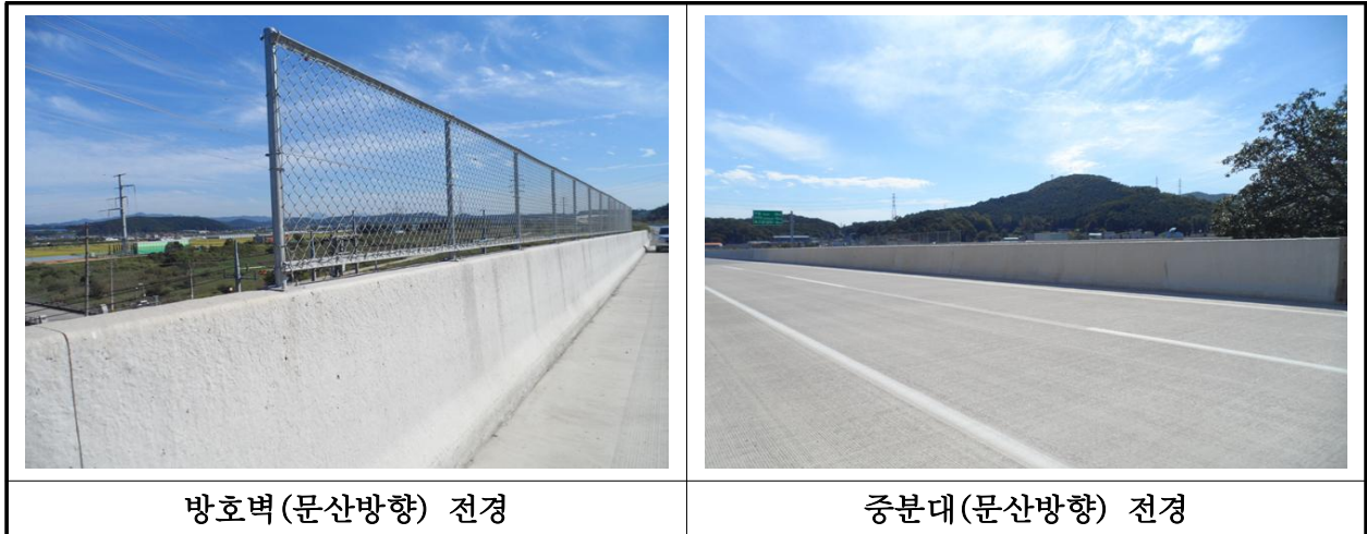
【사진 38.3.42】 방호벽 및 중앙분리대(문산방향) 전경
