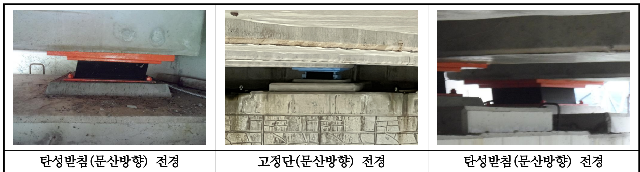
【사진 38.3.31】 교량받침(문산방향) 전경
