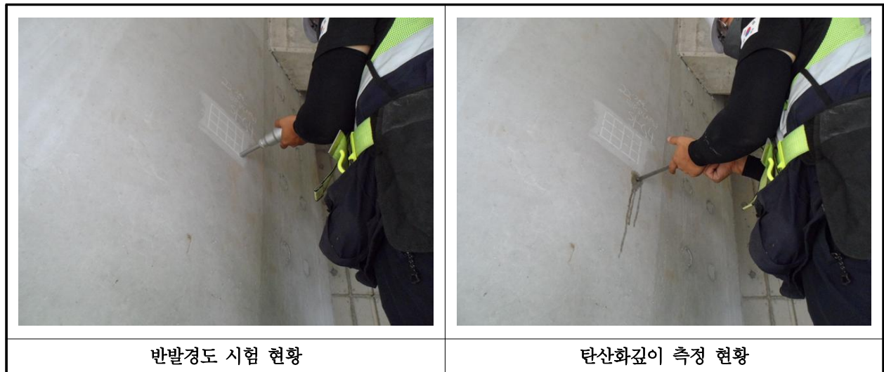
【사진 38.4.1】 콘크리트 내구성조사 현황
