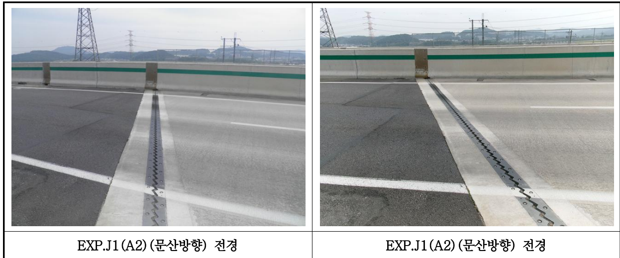
【사진 38.3.35】 신축이음장치(문산방향) 전경
