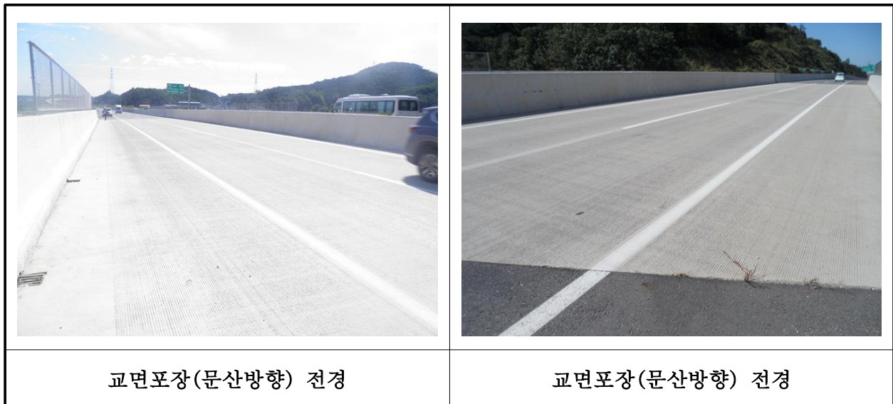
【사진 38.3.38】 교면포장(문산방향) 전경
