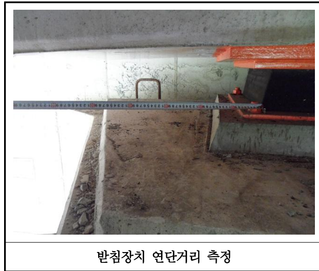
【사진 38.3.33】 교량받침장치 연단거리측정
