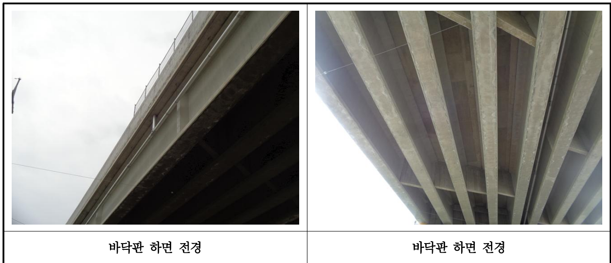
【사진 38.3.23】 바닥판하면(문산방향) 전경
