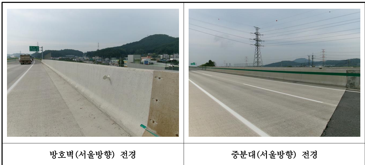
【사진 38.3.21】 방호벽 및 중앙분리대(서울방향) 전경
